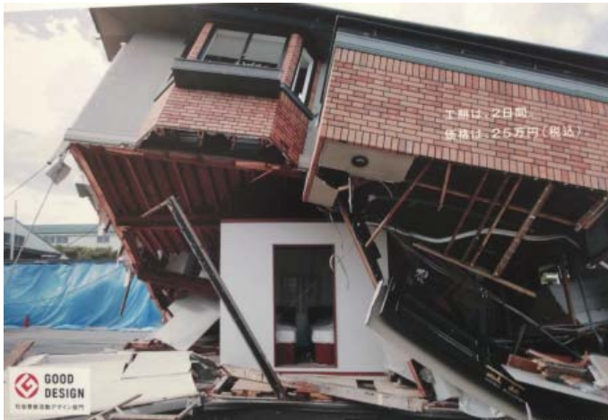
倒壊した住宅と1階部分の耐震シェルター（実験写真）
