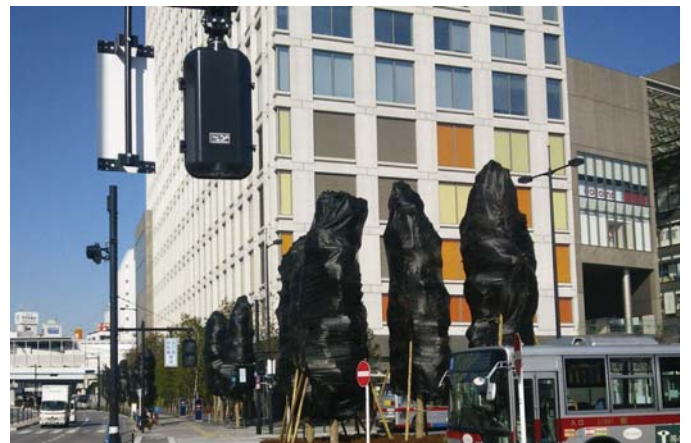
↑二子玉川再開発の現場
