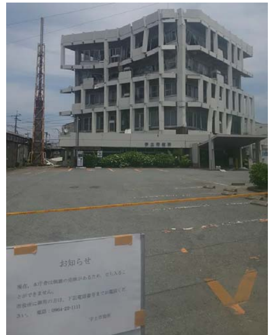
↑大損壊した宇土市役所
